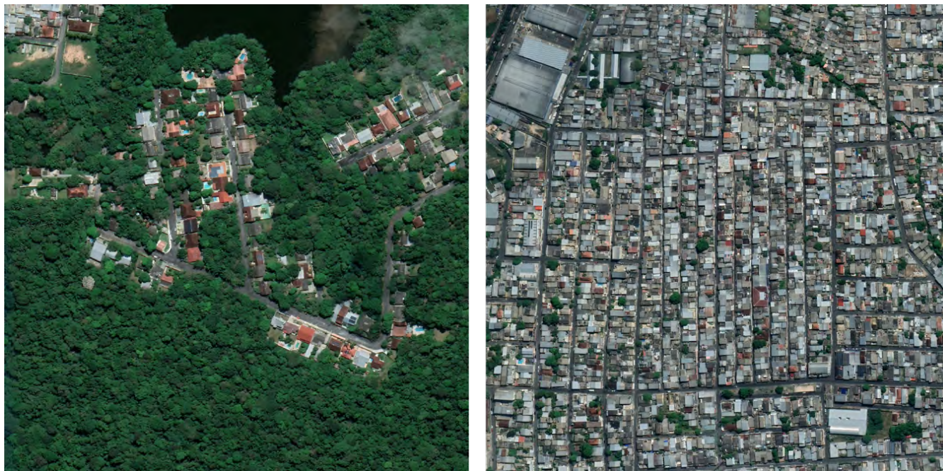
Figura 34.5 Presencia contrastante de infraestructura verde en localidades vecinas de la ciudad de Manaus. (a) Alta permeabilidad de áreas verdes y edificios residenciales en el barrio Acariquara; (b) urbanización con muy baja presencia de calles en el barrio de Ouro Verde.
